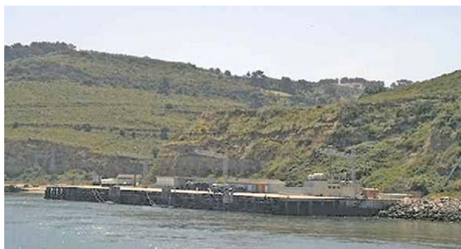
Trafaria (NATO) Fuel Pier
