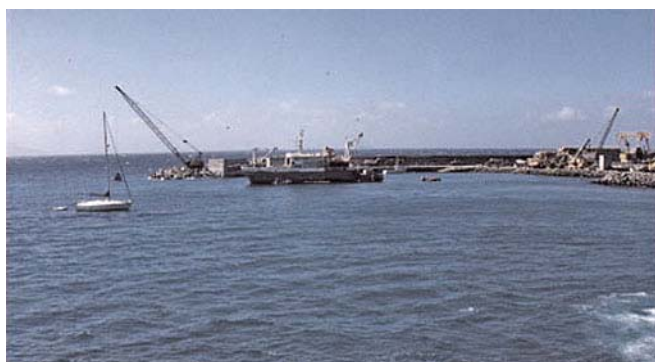
Ilha do Fogo—Ponto de Vale de Cavaleiros
