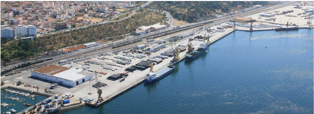
Setubal—Multiuse Terminal I
