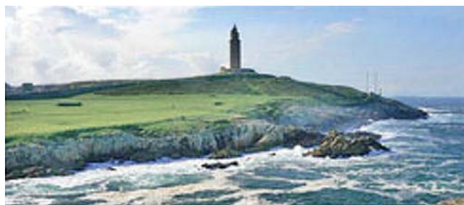
Torre de Hercules Light
